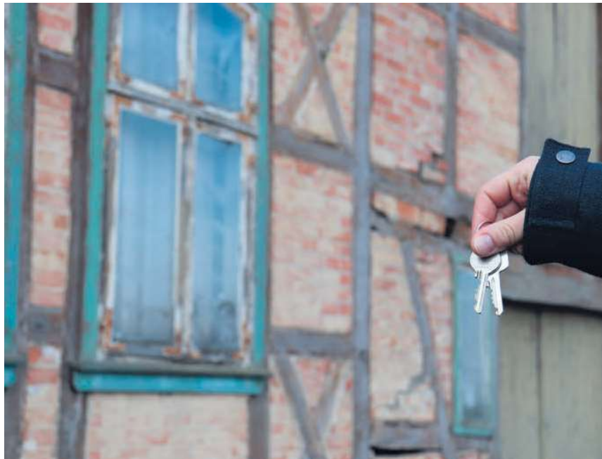
Schließt bald jemand heruntergekommene Gebäude wieder auf? Von einer gemeinwohlorientierten Genossenschaft könnten sie vorher saniert werden, so ein Vorschlag. Aufn.: C. Franke
